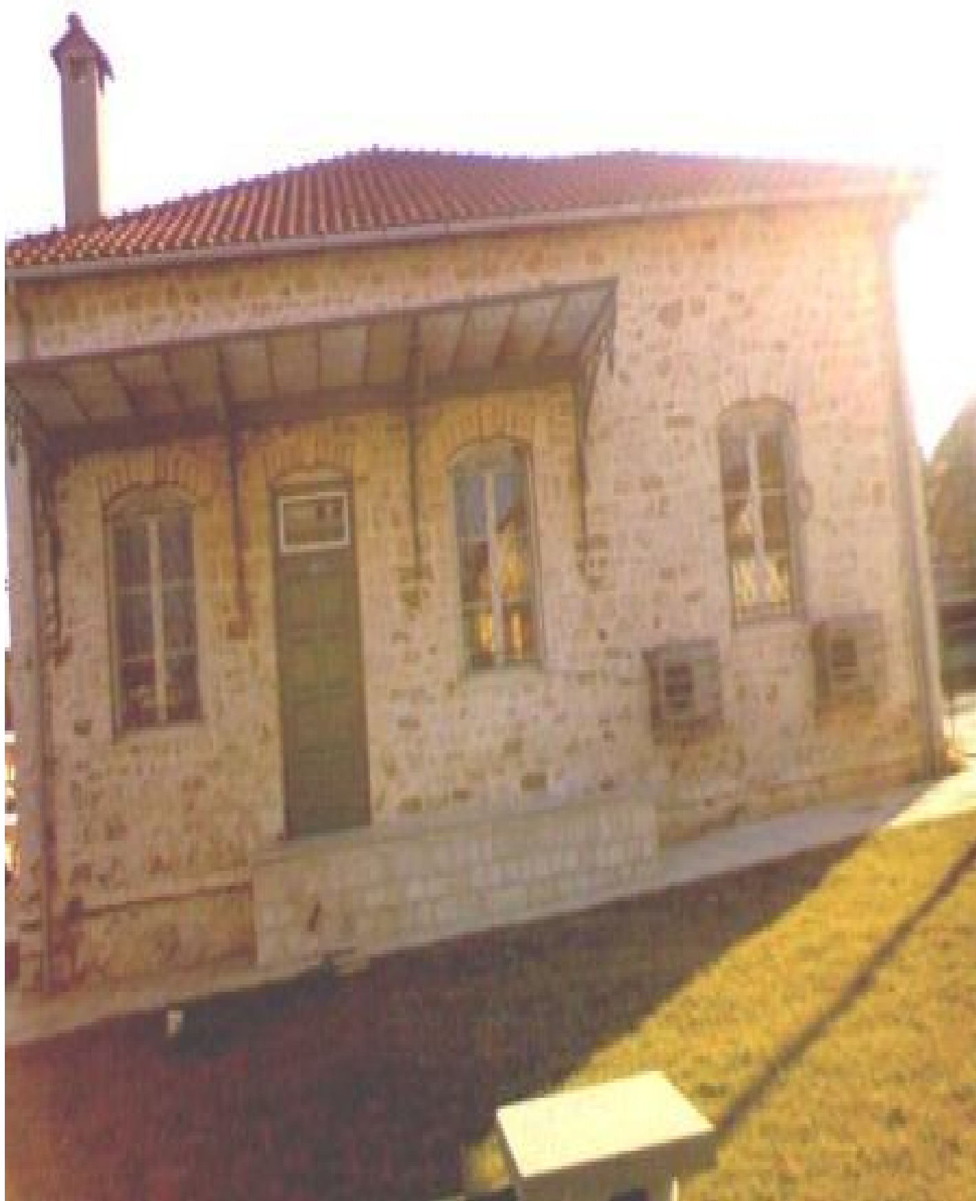
Το κτίριο του παλιού δημοτικού σχολείου Ανατολής, όπως είναι σήμερα, στο οποίο στεγάζεται το Δημαρχείο.
