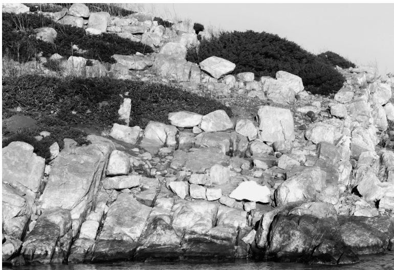
Εἰκ. 14. Ἡ ἔντονα ἀνωφερής «Ἀναβάθρα Π7» στὴν ἀνατολική ἀκτὴ. Ἐν μέρει λαξευμένη στὸν βράχο καὶ ἐν μέρει κτιστή, ἡ ἀναβάθρα διαιρεῖται σὲ δύο ὀρθογώνια βαθμιδωτὰ τμήματα, ποὺ ἀκουμποῦν στὸ ὀγκολιθικὸ ἀνάλημμα τοῦ ἀκρωτηρίου.
