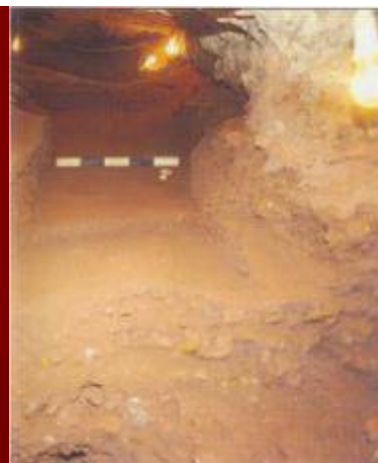
4. Η εξόρυξη στις σκάς του ορυχείου Τ1 γινόταν οριζόντια. Στη σκά 2 τα επόμενα δάπεδα δείχνουν ότι προχωρούσε με διαδοχικό κάλυμα της οροφής.
