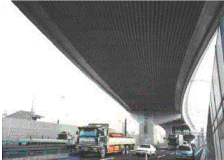
Κατασκευή ηχοαπορροφητική στο κάτω μέρος γέφυρας (Foam Alporas, Shinko Wire, Japan)
